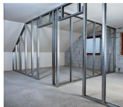
Dry wall Metal stud / UA-profiles
