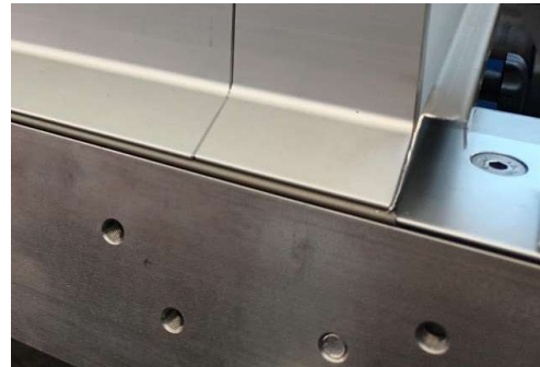
Detailaufnahme von Schritt 7 Die Traufkante sollte 25 mm Tiefe nicht überschreiten.
