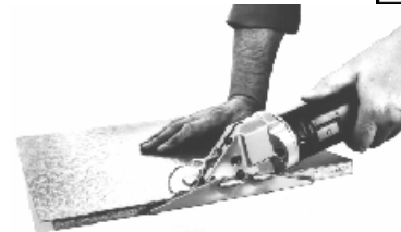
kantenbündiges Schneiden überstehender Platten
